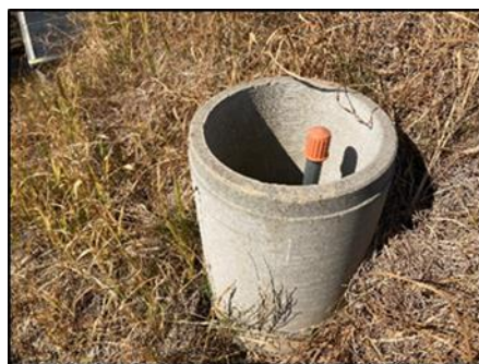
(2)暗渠を閉め切る。
