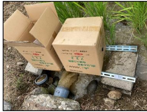
③ブロックに鉄レールを敷き、箱を逆さまに設置
