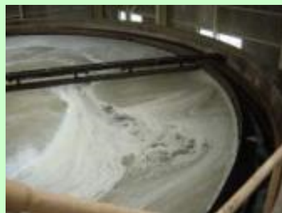
水溶性蛋白の凝集加圧浮上
