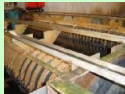
スクリーンプレスによる脱水・脱油
